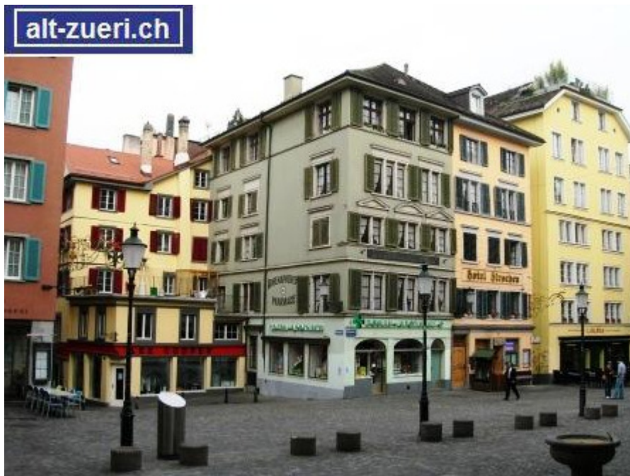
Durch Abbruch eines Hauses entstandener negativer Raum. Hirschenplatz, 8001 Zürich (Photo: Gebr. Dürst)
